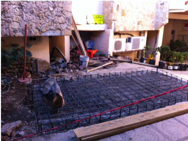
Losa de concreto en construcción.
