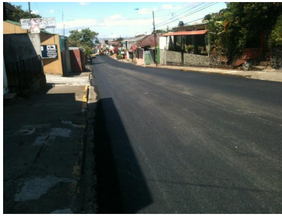
URBANIZACIÓN GÉNESIS (Ejecutado Febrero 2012)
