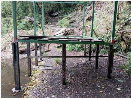
Reconstrucción sobre las columnas de madera antiguas
