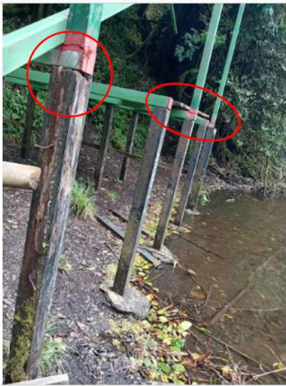
Reconstrucción sobre las columnas de madera antiguas
