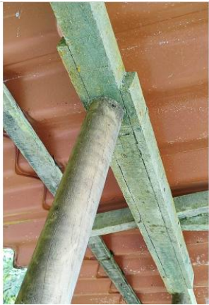
Estructura que soporta el Techo
