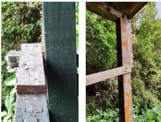
Las uniones con clavos herrumbrados deja en evidencia su antigüedad del mirador
