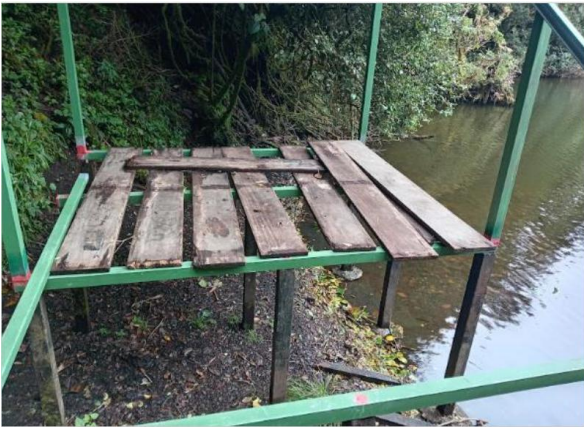
Se reinstalación del piso de madera antiguo
